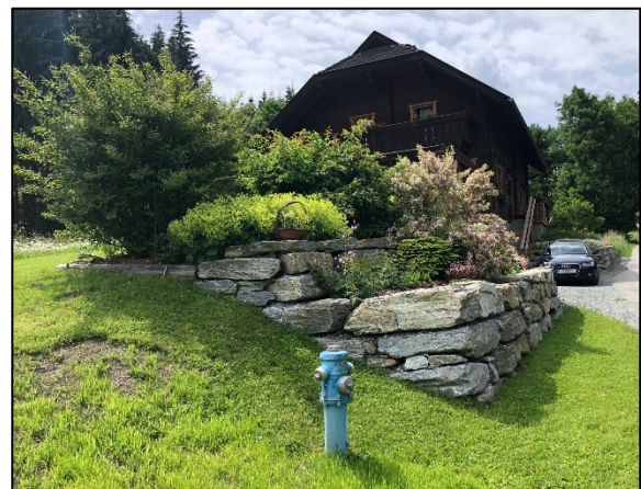
Beispiel für eine Naturstein-Trockenmauer in Privatbereich mit Abstufungen und verhältnismäßig kleinteiligem Steinmaterial
